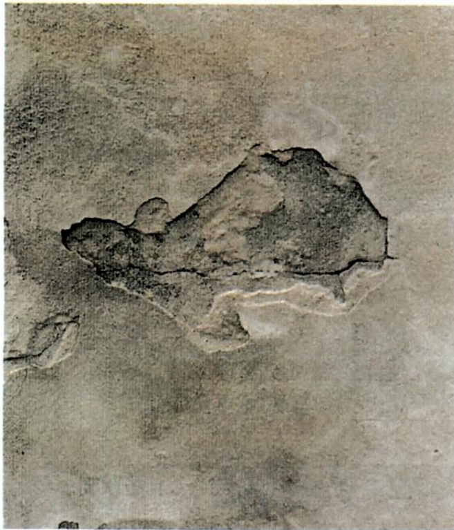
Fot. 3 Uszkodzenie tynku i pęcherze powietrza na kolumnie
