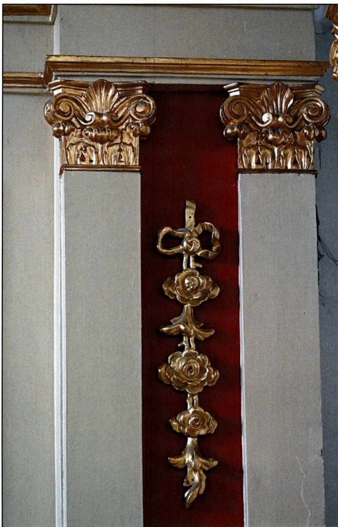
Fot. 9. Fot. 10. Wtórne „złocenia”: brąza na perizonium i szlagmetal na kapitelach, listwach i aplikacjach snycerskich.
