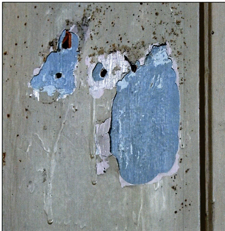
Fot. 17. Przynajmniej trzykrotnie przemalowana struktura ołtarza. Widoczne niestaranne wykonanie i odspajanie się warstw wtórnych,
