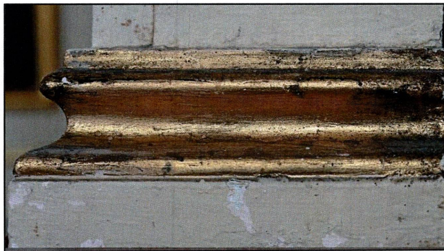
Fot. 15. Fot. 16. Niestarannie wykonane i zniszczone wtórne „złocenia” baz pilastrów.
